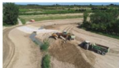
Travaux de suppression de digues défilantes et renaturation du Briançon à Théziers (ci-dessus) - Prélèvement réalisé dans le cadre d'une étude sur les eaux souterraines (ci-contre)
